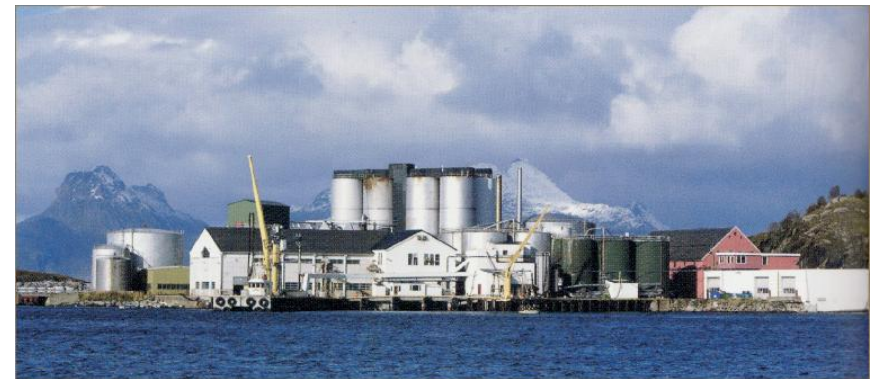
Bodø Sildoljefabrikk AS
